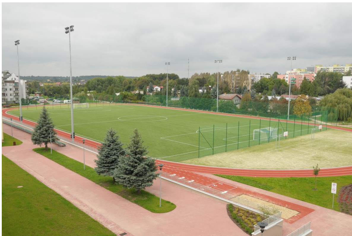
Zdjęcie 2. Realizacja projektu - Gimnazjum nr 16 - boisko ze sztuczną trawą - wymiary boiska 105 m x 68 m, z oświetleniem na 250 lux. i 500 lux.
